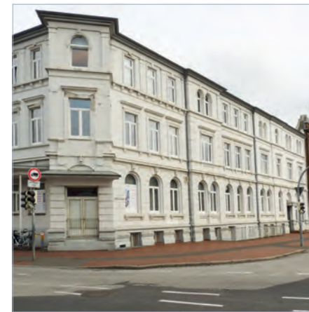
Abb. 10 | Ehemaliges Bahnhofshotel an der Viktoriastraße
