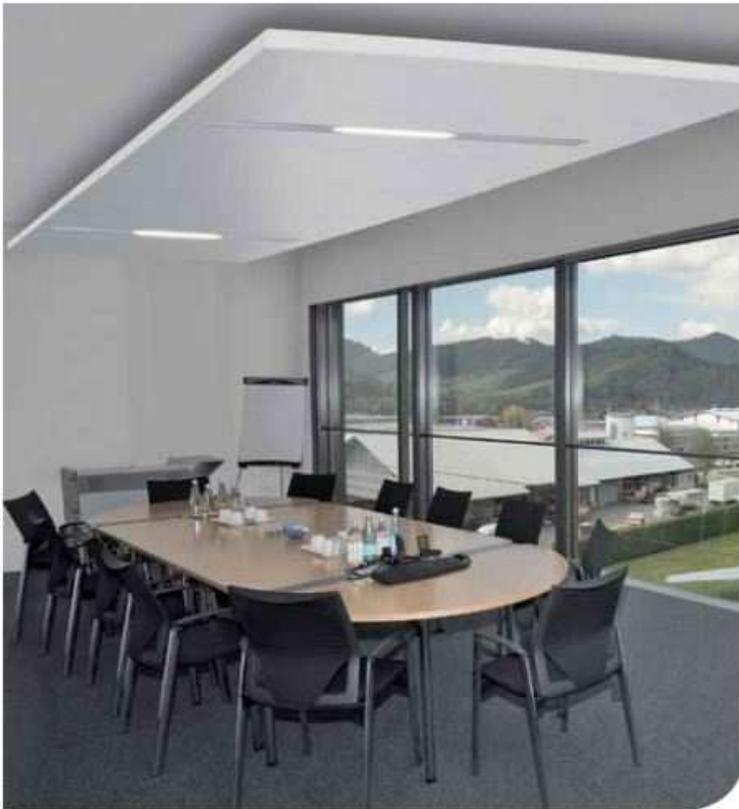
Abbildung 6: Deckensegel als Strahlungsheizung
