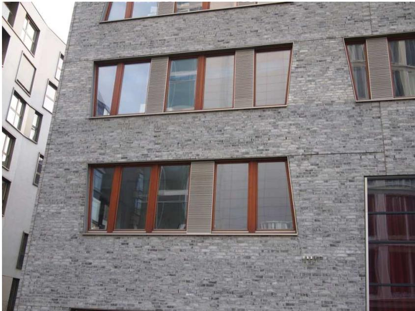
Abbildung 7: Fenster mit Wetterschutzlamellen
