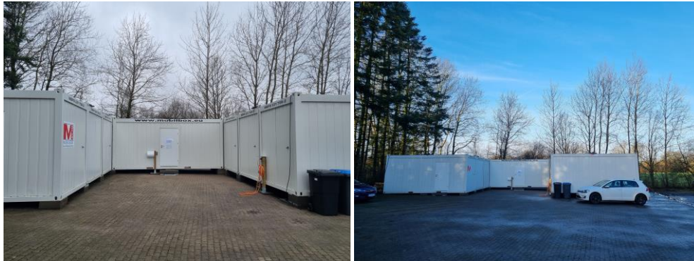
Die neue Rettungswache wurde in einer Containerbauweise errichtet.
