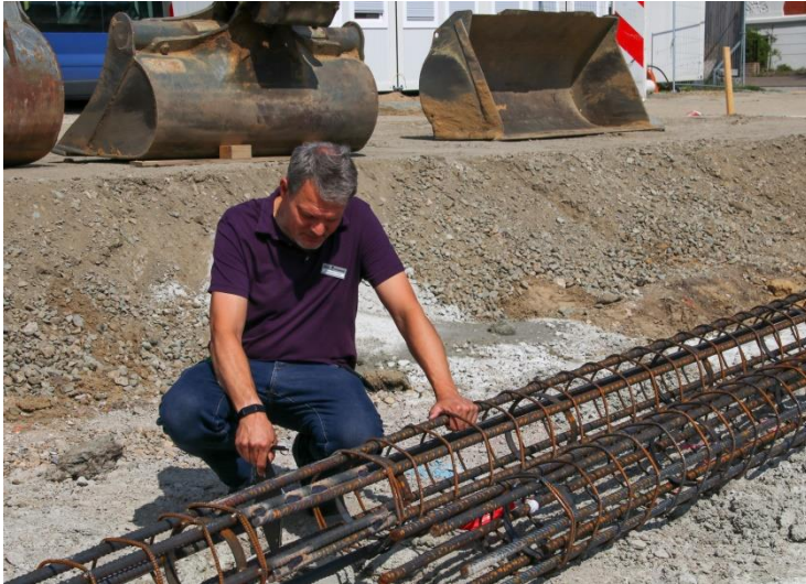
Johannes Lindner, Projektleiter Kreishausneubau, erläutert die Funktion der Bewehrungskörbe
