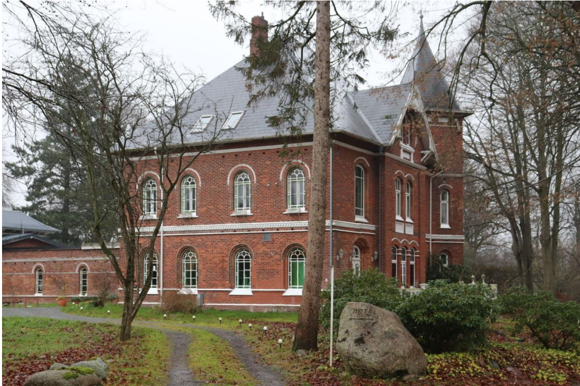
Das Gutshaus in Kleve
