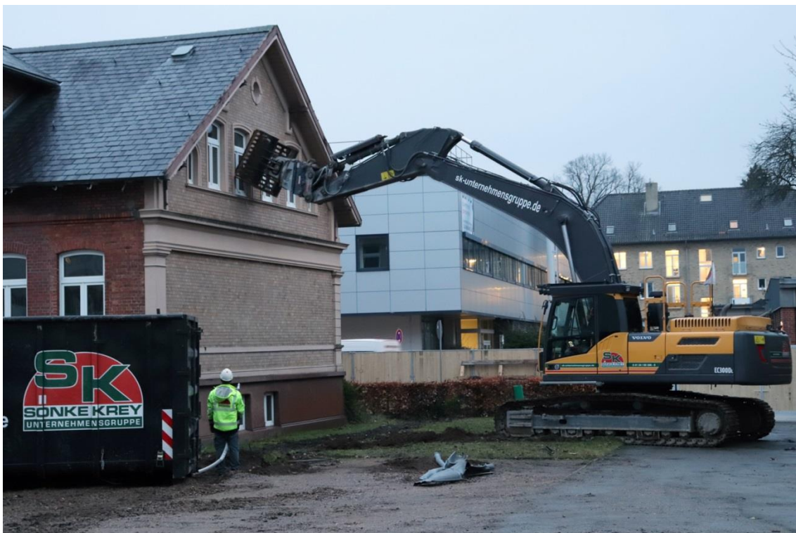
Der Bagger geht ins Gebäude – wie der Fachmann sagt
